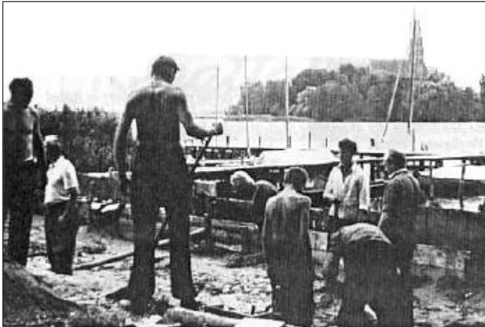
Vereinsmitglieder errichten die ersten Steganlagen
